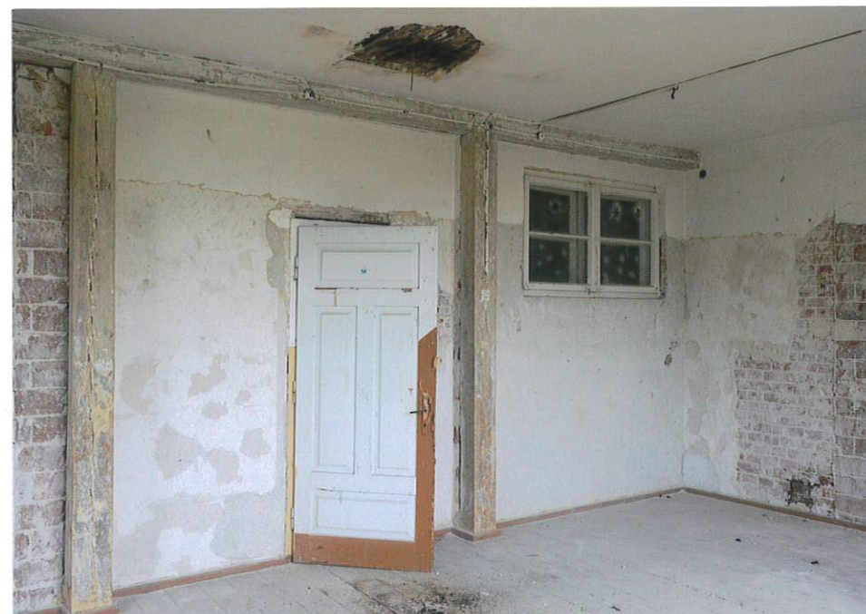
Fot. 6. Pomieszczenie piętra ze słupami i doświetleniem klatki schodowej, 2019.
